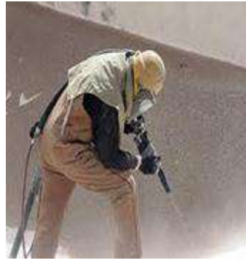
تصویر شماره ۵۱: عملیات سندبلاستینگ
