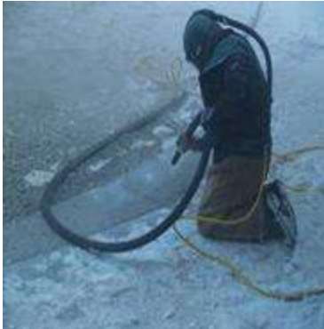
تصویر شماره ۵۱: عملیات سندبلاستینگ
