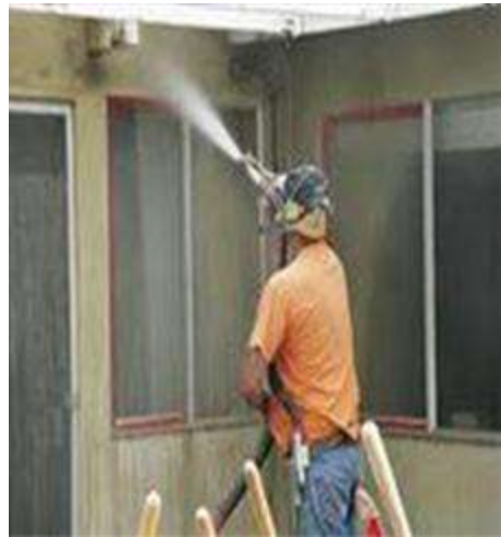
تصویر شماره ۱۶: تصاویر عملیات سندبلاستینگ
