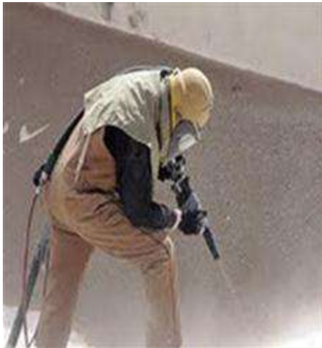
تصویر شماره ۱۶: تصاویر عملیات سندبلاستینگ
